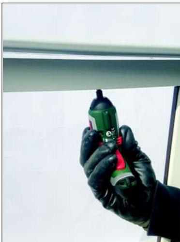
Rimontare la guida superiore e fissarla con le viti
