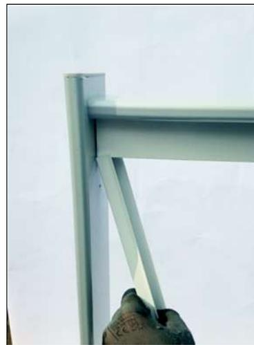
Posizionare il profilo portamagnete e segnare i punti di fissaggio.
